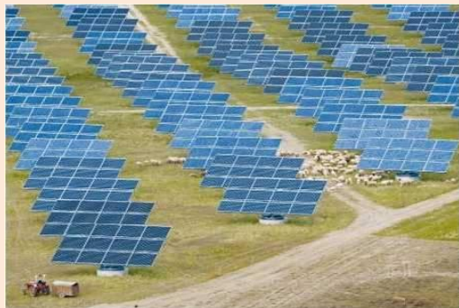
שדה סולארי פוטו-וולטאי בו הפאנלים מונחים על מערכות עקיבה ושנעשה בשטחו מתחת לפאנלים שימוש חקלאי.
