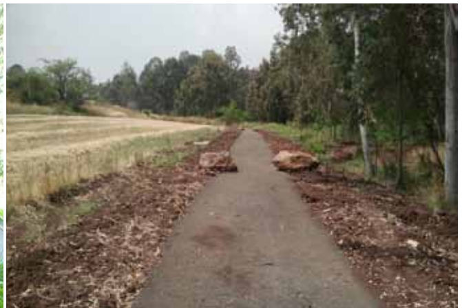
שביל אופניים נחל תבוא-עין דור, הצבת בולדרים לרוחב השביל למניעת מעבר כלי רכב
